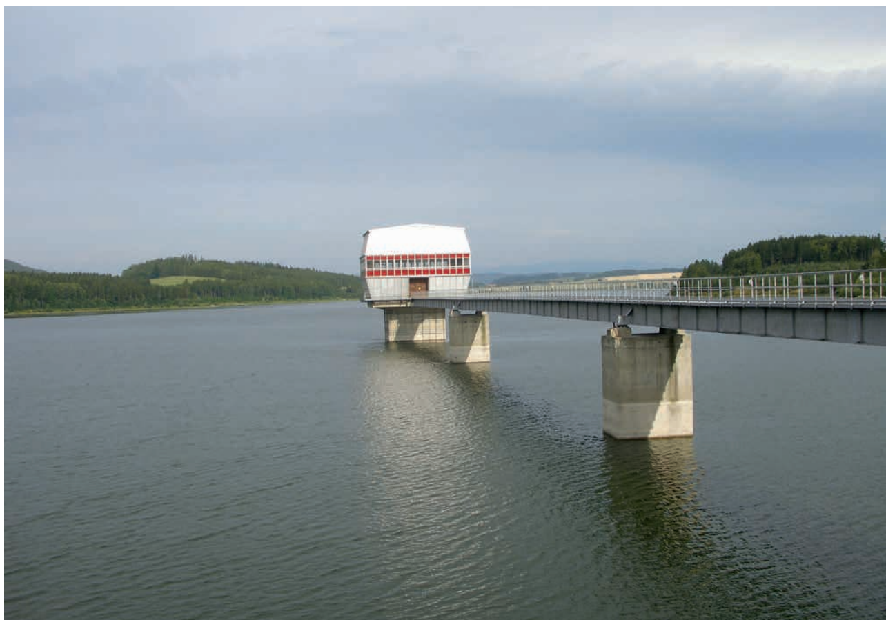
The Slezská Harta Dam - collection tower (source: Oder River Board, s. e.)
