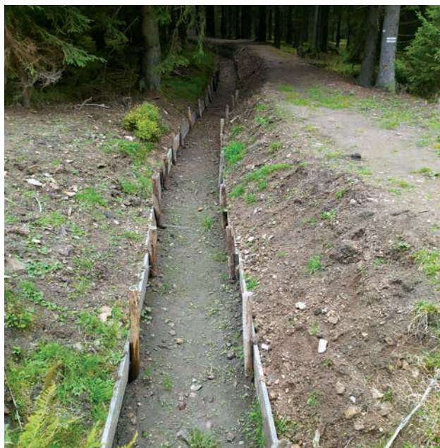
Blatenský příkop, oprava opevnění (autor: Hubalová Petra)
