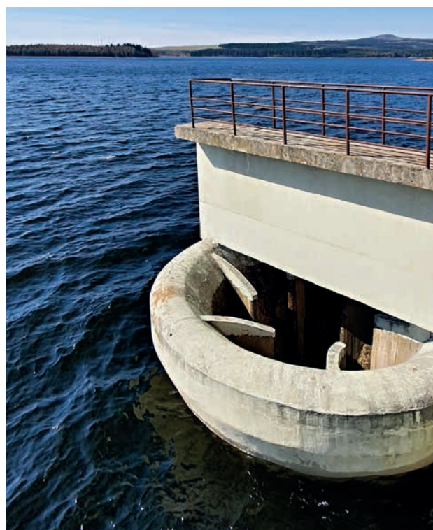
The Přisečnice Dam, Spillway (source: Ohře River Basin, s.e.)
